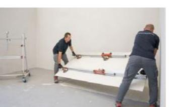
IT 5 Mediante il telaio di movimento con ventose di sicurezza accompagnare la lastra in posizione e posarla.
