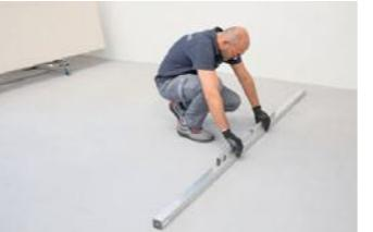
IT 1 Prima di procedere con la posa verificare che il fondo sia perfettamente planare, asciutto e pulito. Utilizzare i collanti descritti miscelati in base alle specifiche indicate nella scheda tecnica del collante prescelto. Si raccomanda l'utilizzo di adesivi cementizi ad alte prestazioni in classe C2 o superiore.
