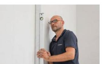
IT 1 Prima di procedere con la posa verificare che il fondo sia perfettamente planare, asciutto e pulito. Utilizzare i collanti descritti miscelati in base alle specifiche indicate nella scheda tecnica del collante prescelto. Si raccomanda l'utilizzo di adesivi cementizi ad alte prestazioni in classe C2 o superiore. Si suggerisce l'utilizzo di adesivi a sciolamento verticale nullo (caratteristica identificata dalla lettera T).
