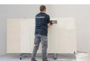
IT 4 Stendere il collante sul retro della lastra utilizzando l'apposita spatola a denti quadrati (3x3 mm) e accertarsi che le righe dell'ultima stesura siano nella stessa direzione di quelle della spalmatura della lastra. Durante la fase di stesura, la lastra dovrà essere in posizione verticale e fissata al telaio di movimento con ventose di sicurezza posate sopra al carrello per il trasporto con ruote.
